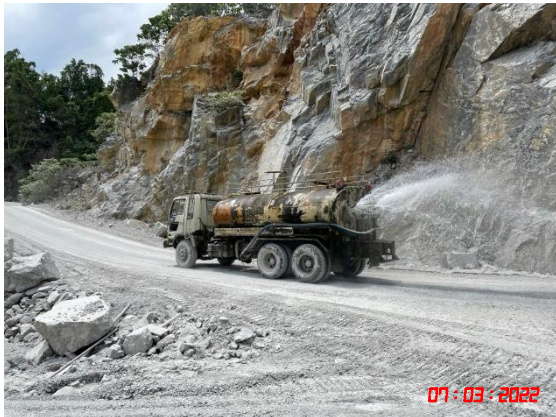
รูปที่ 2-8 การฉีดพรมน้ำเพื่อลดการฟุ้งกระจายของฝุ่นละออง
