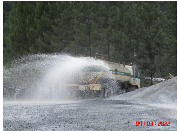
รูปที่ 2-8 การฉีดพรมน้ำเพื่อลดการฟุ้งกระจายของฝุ่นละออง
